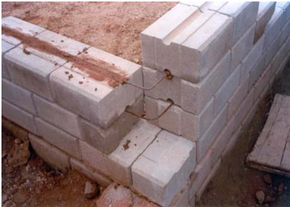
Figure 6. Bonding -Steel Bars & Conduits
